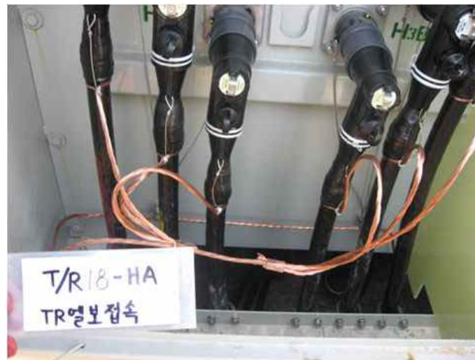
圖 4-83 亭置式變壓器二次側接地端子之接地線連接方式
