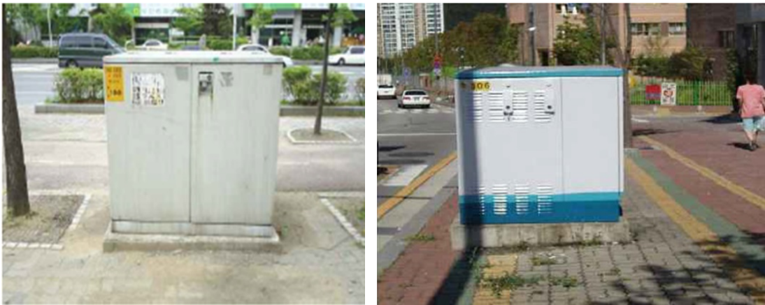
圖 4-77 亭置式變壓器安裝於人行道上
