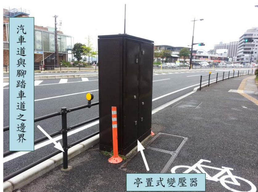
圖 4-61 日本中電下關地區亭置式變壓器設置於腳踏車道旁
