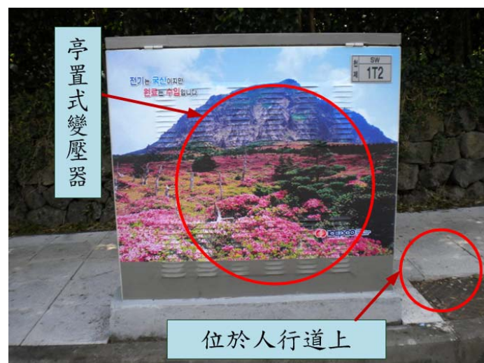
圖 4-102 韓國光州地區亭置式變壓器設置於人行道
