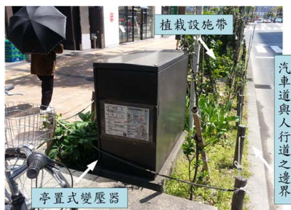
圖 4-58 日本九州福岡地區亭置式變壓器設置於人行道植栽帶
