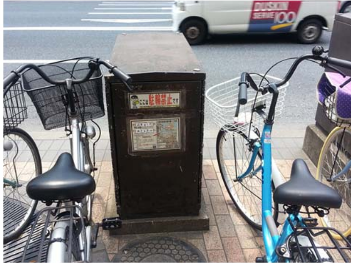
圖 4-56 日本九州福岡地區亭置式變壓器設置於腳踏車道
