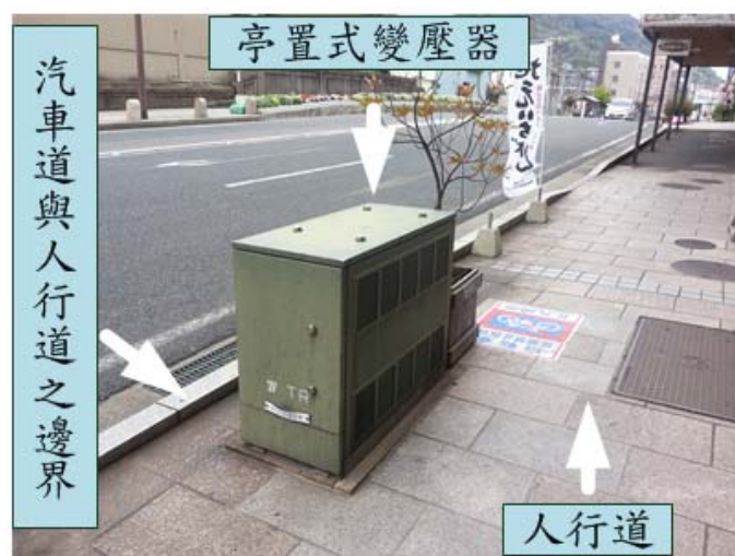
圖 4-65 日本中電下關地區亭置式變壓器設置於人行道旁
