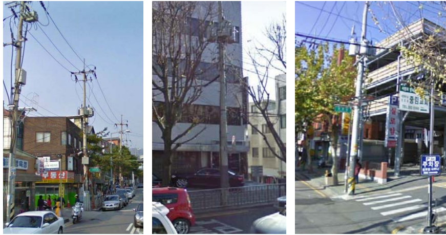
圖 4-97 韓國首爾住宅區桿上變壓器設置於主要道路旁之情形
