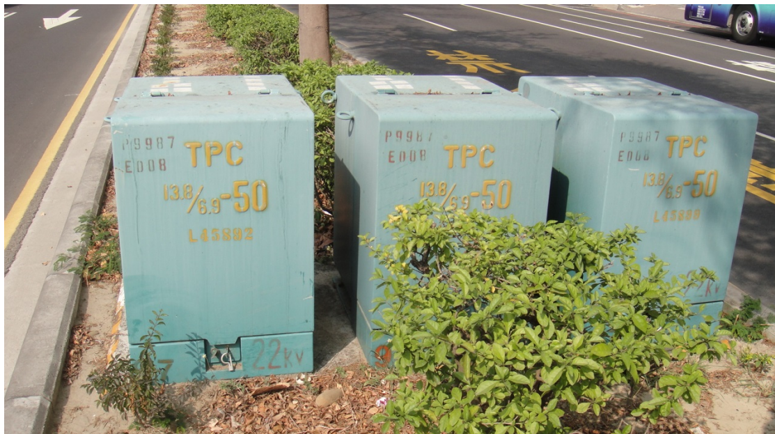
圖 3-9 三具變壓器設置於分隔島之情形
