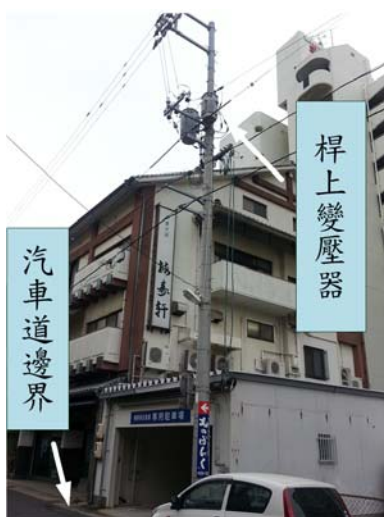
圖 4-67 日本中電下關地區桿上變壓器設置於民宅旁
