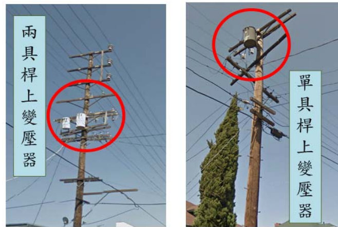
圖 4-6 洛杉磯地區桿上變壓器之配置情況
