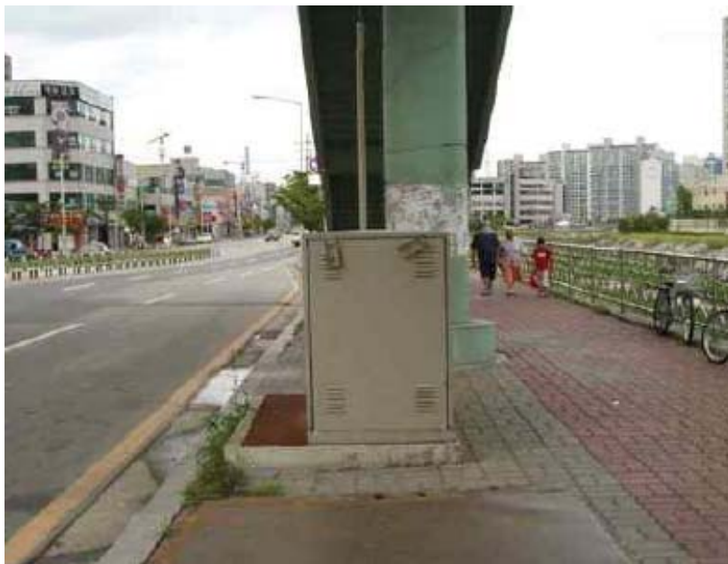
圖 4-78 亭置式變壓器安裝於行人天橋下
