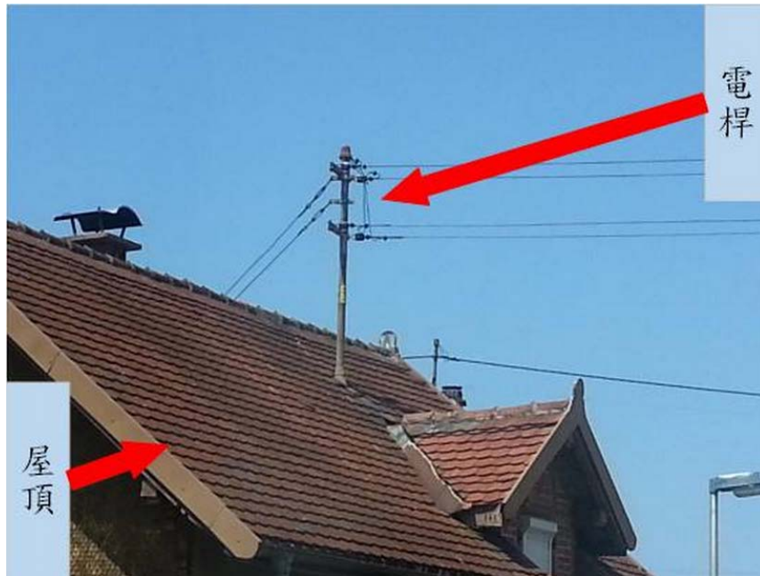
圖 4-29 德國慕尼黑地區電桿設置於屋頂處實照
