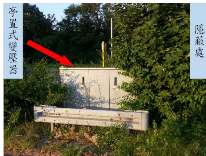
圖 4-23 德國海德堡地區亭置式變壓器設置於隱蔽處
