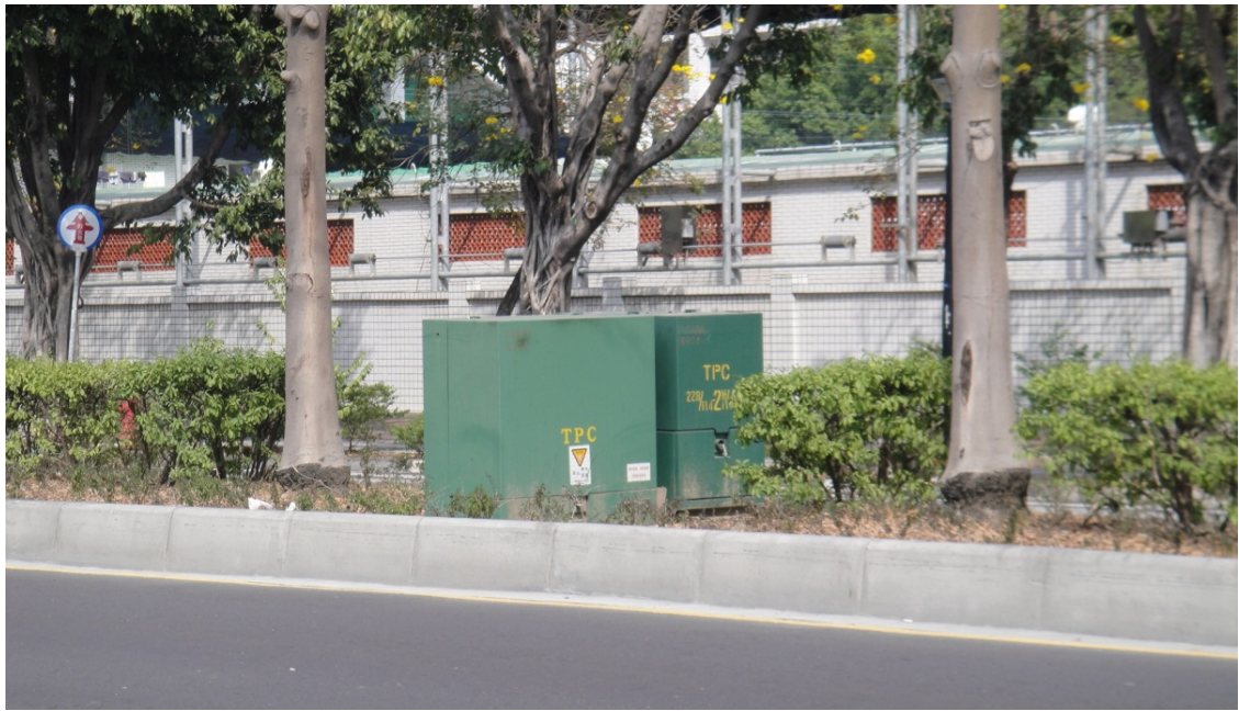
圖 3-8 單具變壓器設置於分隔島之情形
