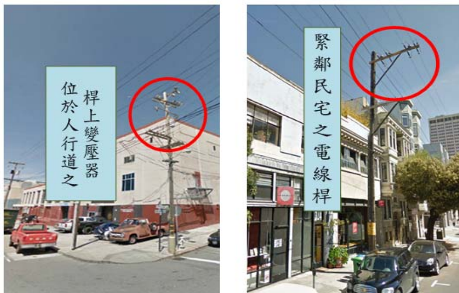
圖 4-3 舊金山地區人行道上電桿及桿上變壓器之實際設置圖
