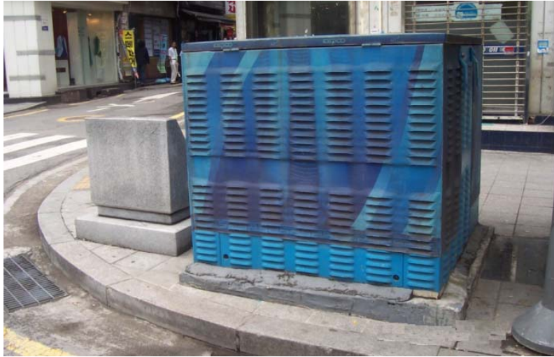
圖 4-79 亭置式變壓器設置於道路轉角路口
