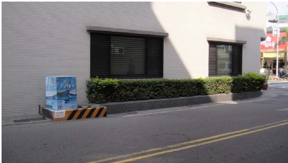
圖 3-11 單具變壓器設置於路基邊緣之情形
