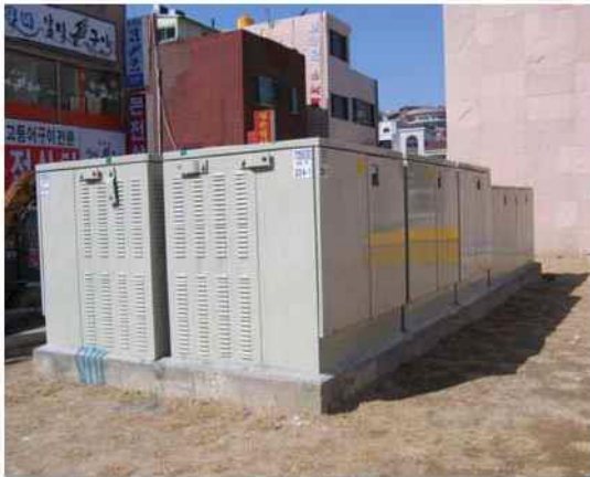
그림 9 동일 장소 밀집 설치 (지양)
