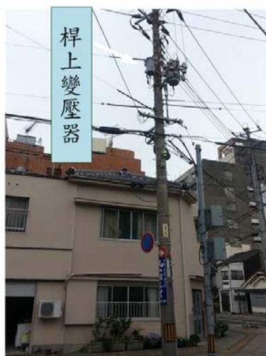
圖 4-68 日本中電下關地區桿上變壓器設置於路口轉彎處
