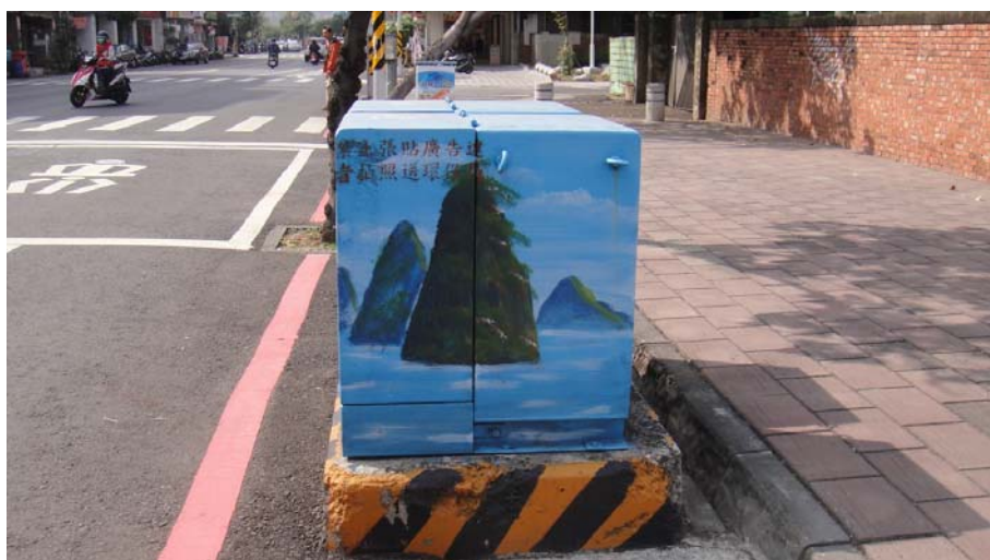
圖 3-14 雙具變壓器設置於路肩外緣之情形
