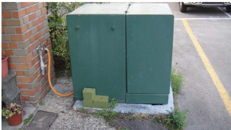
圖 3-15 單具變壓器設置於民宅前之情形
