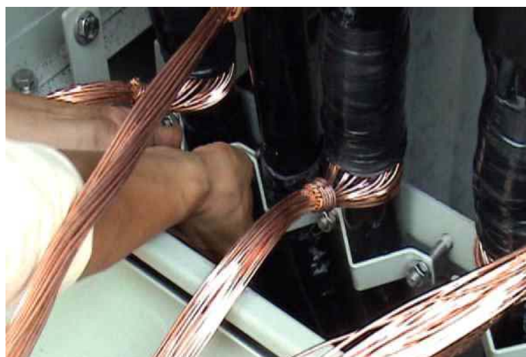
圖 4-84 使用 U 型螺栓固定電纜與接頭之示意圖
