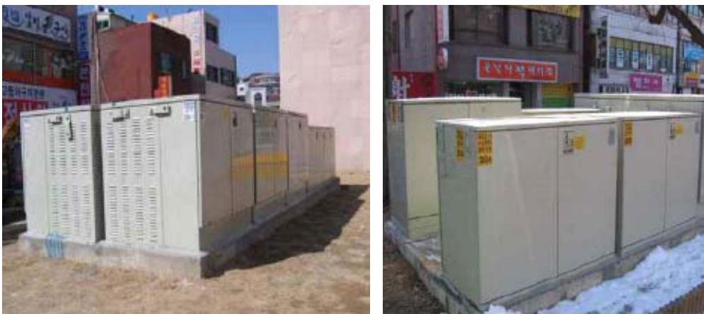
圖 4-74 配電設備應避免密集設置於相同場所
