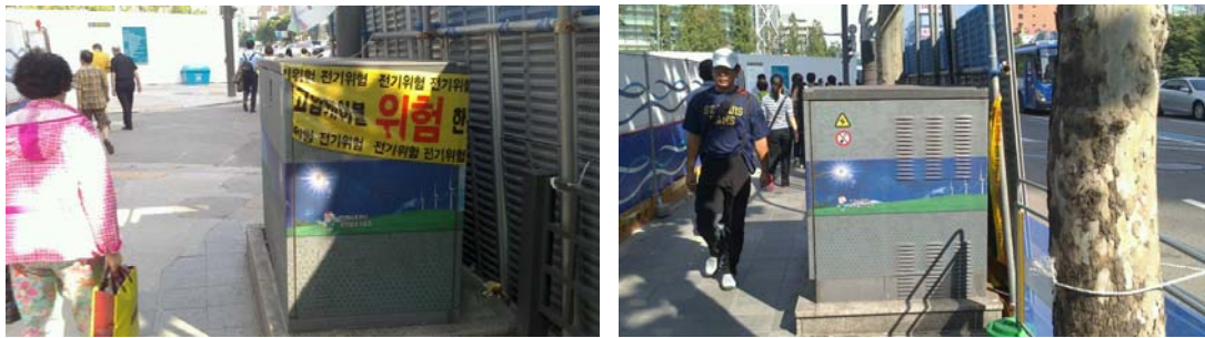
圖 4-95 韓國首爾商業區人行道設置配電變壓器之情形
