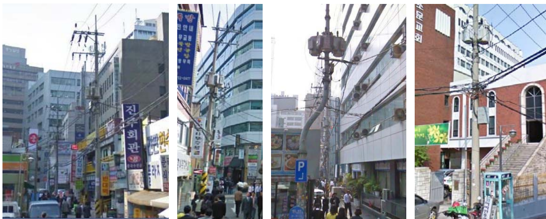
圖 4-96 韓國首爾住商混合區配電變壓器設置於狹小巷弄之情形
