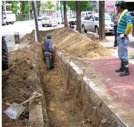
圖 4-80 埋設接地銅棒
