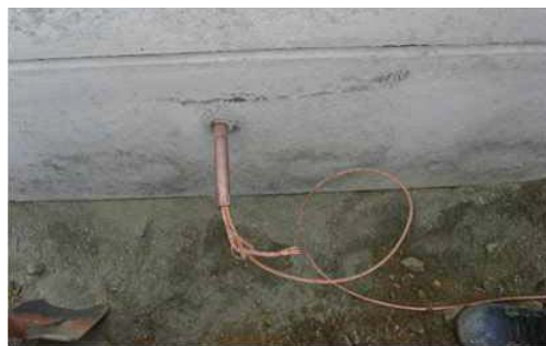
圖 4-81 於基礎台上設置接地線
