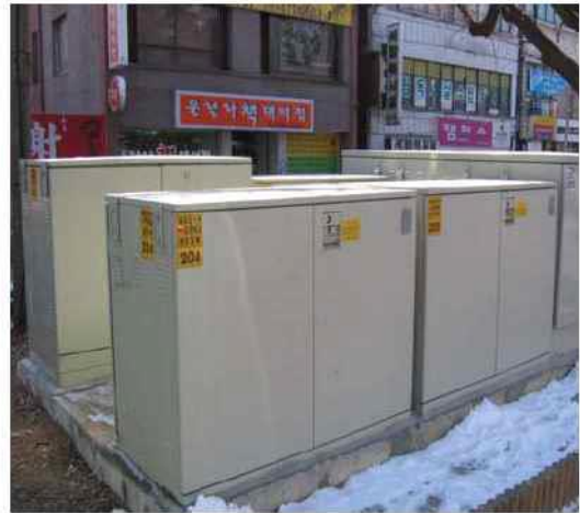
그림 9 동일 장소 밀집 설치 (지양)
