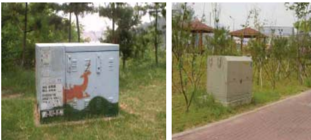
圖 4-76 亭置式變壓器安裝於綠地上
