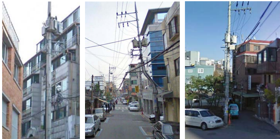
圖 4-98 韓國首爾住宅區桿上變壓器設置於巷道之情形
