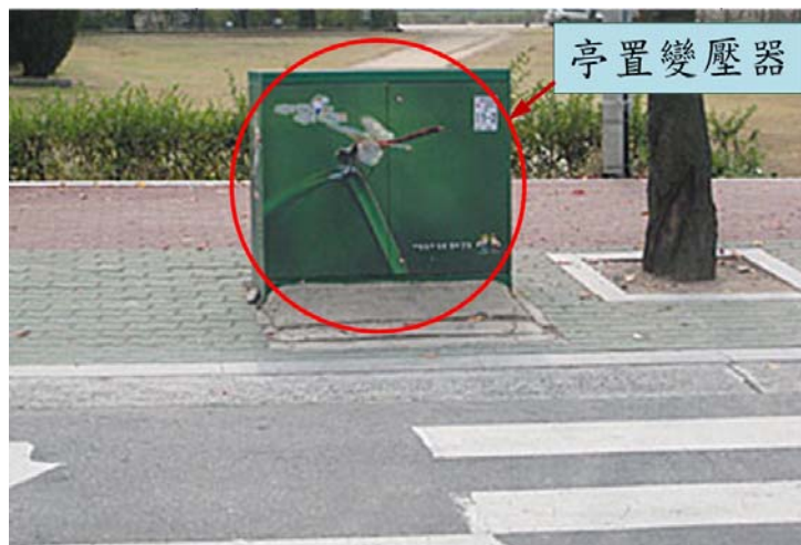
圖 4-100 韓國仁川地區亭置式變壓器設置於道路旁
