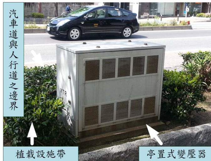
圖 4-57 日本九州福岡地區亭置式變壓器設置於汽車道植栽帶
