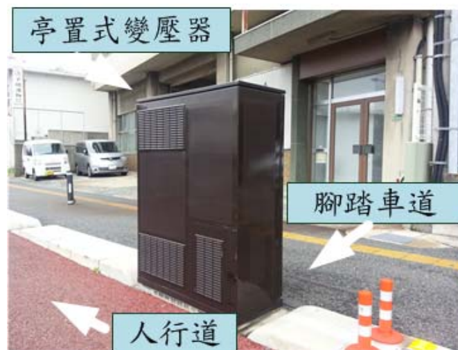
圖 4-64 日本中電下關地區亭置式變壓器設置於民宅門口
