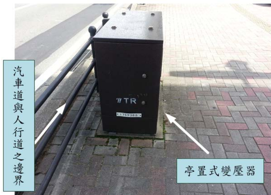
圖 4-55 日本九州福岡地區亭置式變壓器設置於人行道
