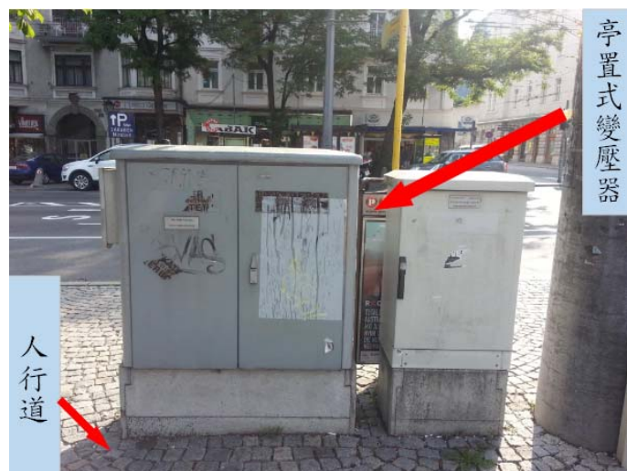
圖 4-24 德國慕尼黑地區亭置式變壓器設置於人行道處
