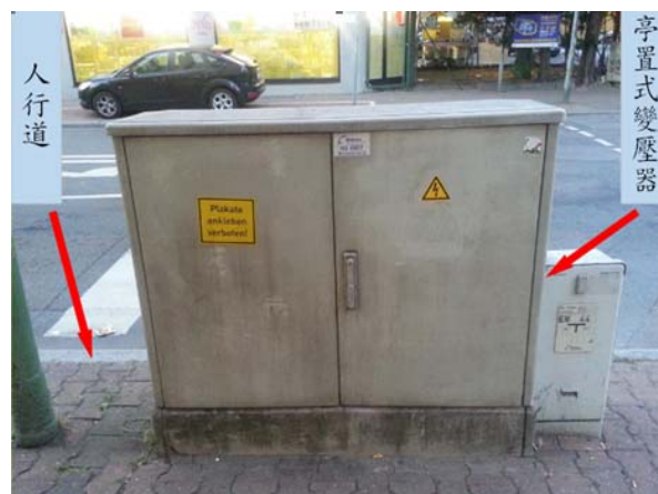
圖 4-20 德國法蘭克福地區亭置式變壓器設置於人行道
