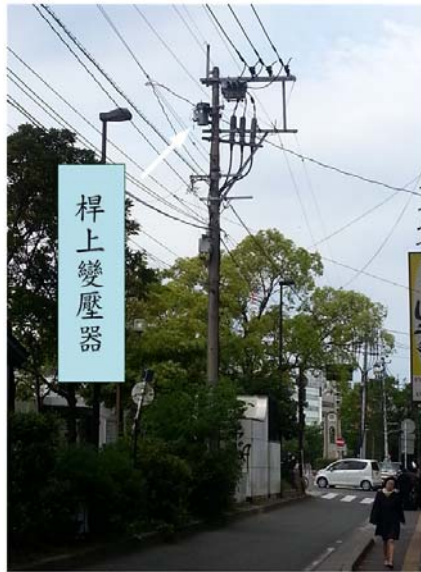
圖 4-59 日本九州福岡地區桿上變壓器及其附屬設施設置於巷道
