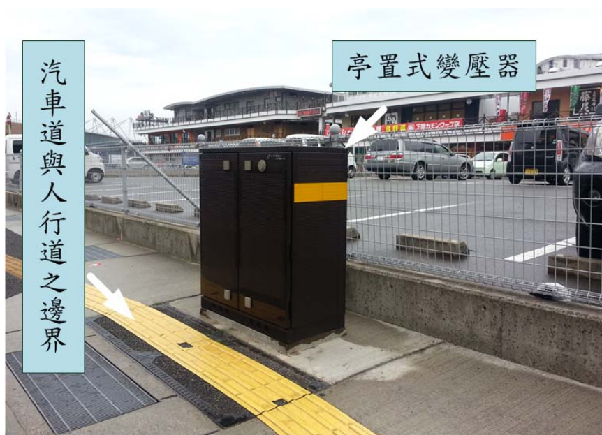
圖 4-62 日本中電下關地區亭置式變壓器設置於人行道旁
