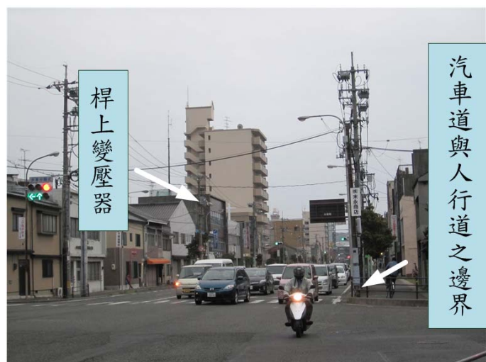
圖 4-66 日本中電下關地區桿上變壓器設置於汽車道與人行道間
