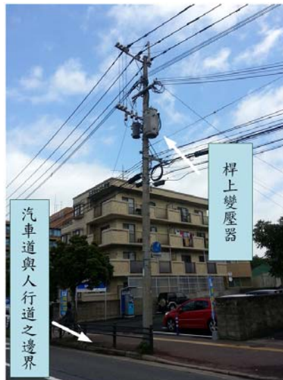
圖 4-60 日本九州福岡地區桿上變壓器設置於汽車道與人行道間
