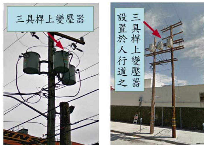
圖 4-7 洛杉磯地區三具桿上變壓器之實際設置情況
